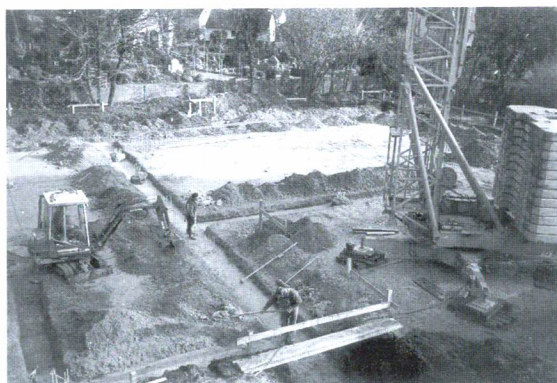
Ein Blick auf die Baustelle; Fotos: G. Adams
